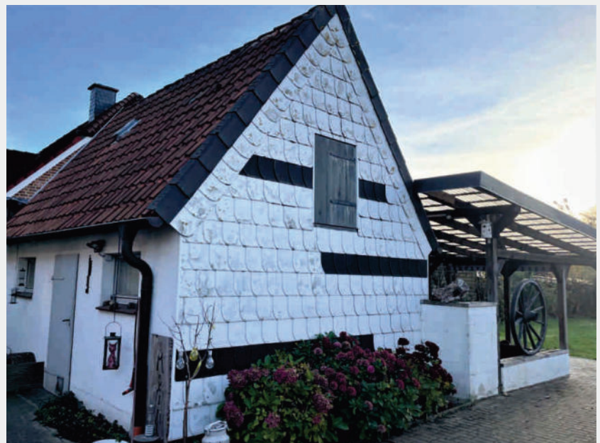
Das Gartenhaus und der überdachte Freisitz
