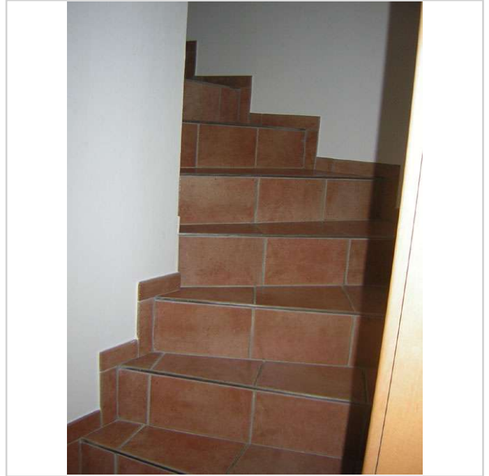
Die Treppe mit Terrakottaflies
